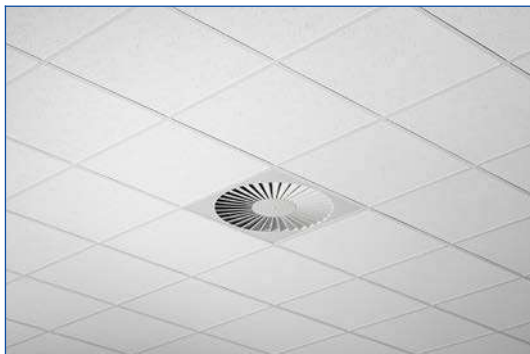
Монтаж в потолки с Т-образными профилями
