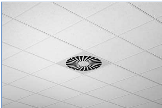
Монтаж в потолки с Т-образными профилями
