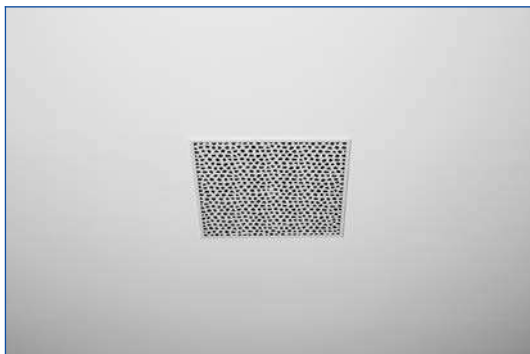
Монтаж в сплошные подвесные потолки
