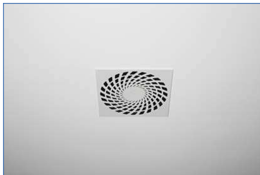
Монтаж в сплошные подвесные потолки
