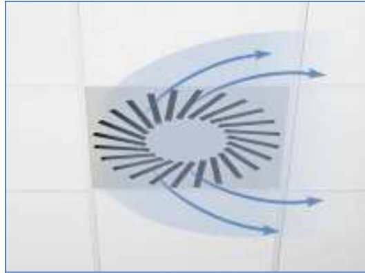
Горизонтальная подача воздуха в одном направлении
