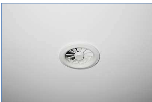
Монтаж в сплошные подвесные потолки
